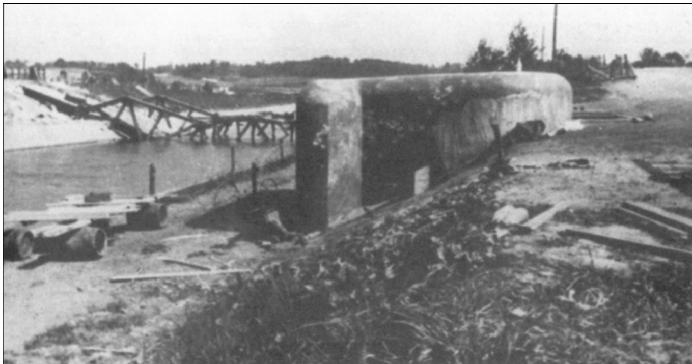
Im Hintergrund sieht man die Brücke von Canne, oder Kanne, welche die Belgier noch zu zerstören vermochten, ehe die vorrückenden deutschen Truppen sie überqueren konnten. Andere, nahegelegene Brücken konnten sie hingegen nicht mehr sprengen. Im Vordergrund ist eine Beobachtungs-Kasematte zu erkennen.
